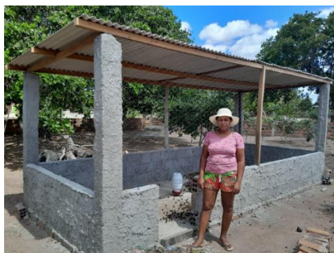
Figura 12. Construção de galinheiro com recurso do Fomento Rural – aperfeiçoamento da avicultura
